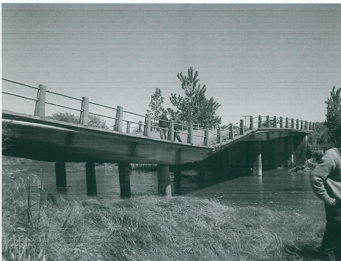
El puente se ha quebrado, tiene un daño muy importante, se ha descalzado así que no se puede transitar por él, la ruta está cortada, el puente no se cayó, se han socavado las bases producto de la fuerza del agua y produjo la rotura.
