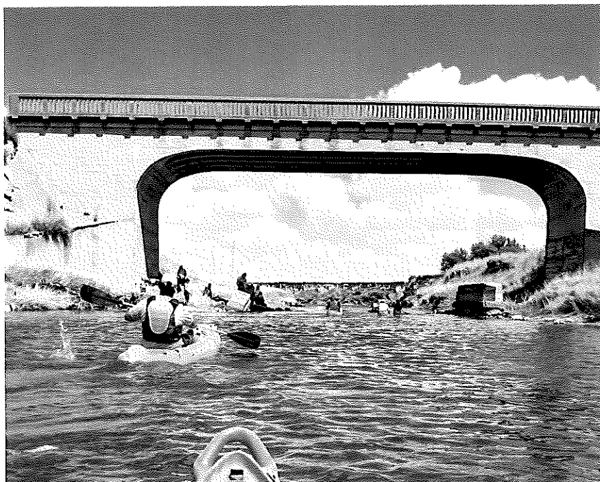
Kayakistas navegando por el Río Quequén Salado bajo el Puente Vanoli.
