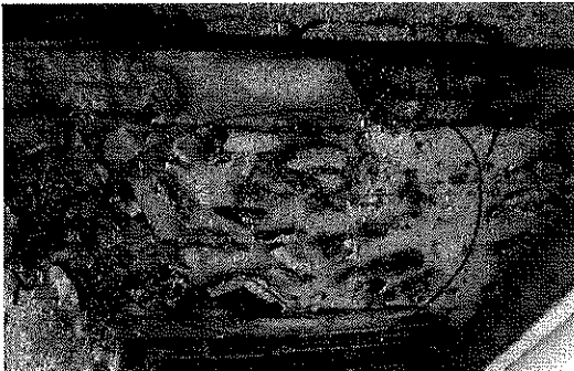
Foto 30. Desprendimiento Recubrimiento
