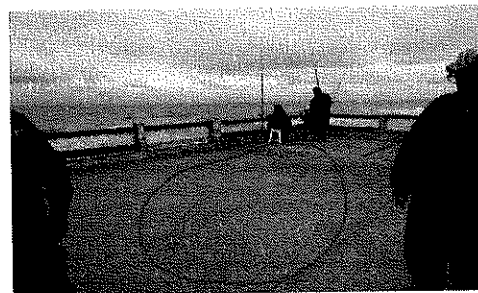
Foto 18. Desgaste Superficial Importante
