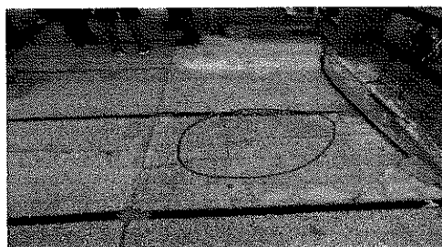
Foto 5. Reparacion Losa y Desgaste Superficial
