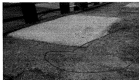
Foto 5. Reparacion Losa y Desgaste Superficial
