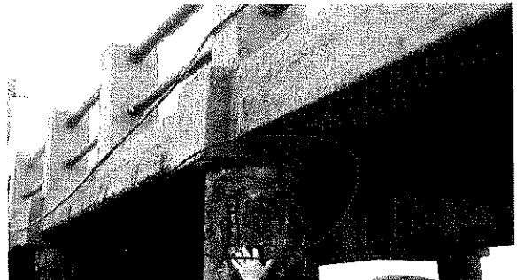
Foto 25. Perdida de recubrimiento y oxidación armadura
