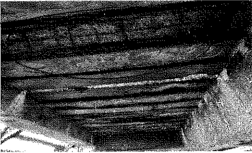
Foto 30. Desprendimiento Recubrimiento
