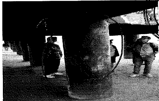
Foto 25. Perdida de recubrimiento y oxidación armadura
