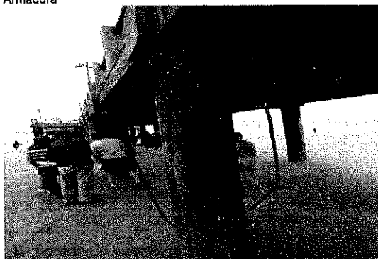
Foto 27. Perdida de recubrimiento y de estructuralidad con Oxidación Armadura
