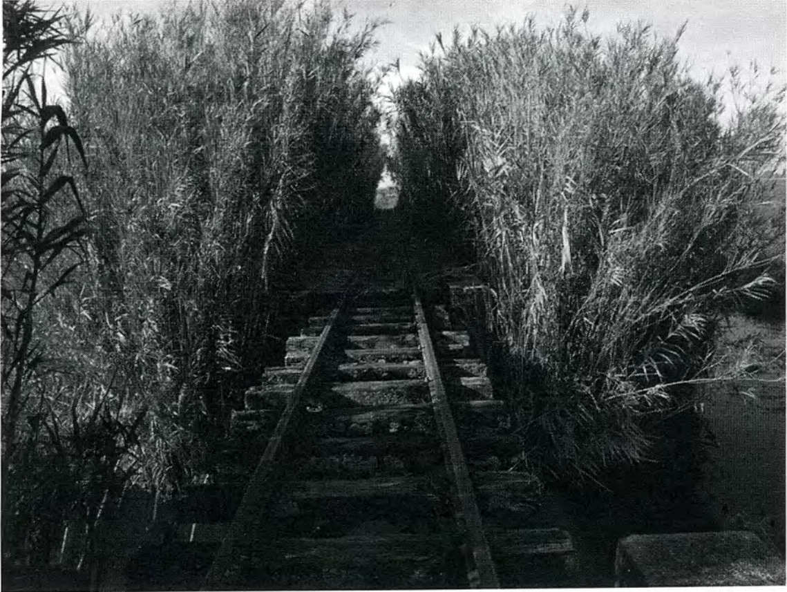
Puente de la estación la valerosa
